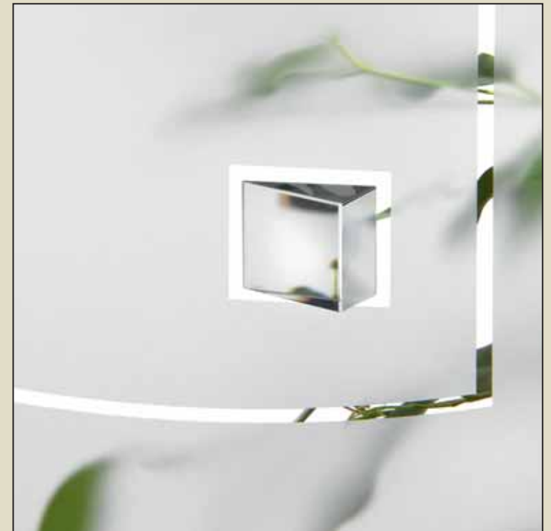
Das teilmattierte Glas wird durch die Applikation geschliffener Glaskeile geschickt akzentuiert.
